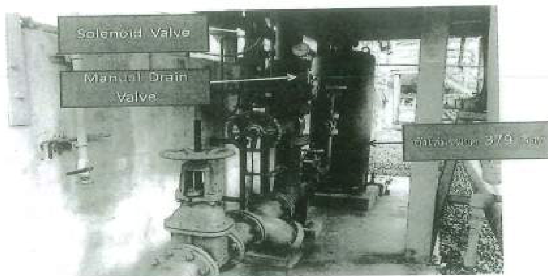
รูป Deluge Valve และ Tank Foam ระบบ Fire Fighting Diesel Oil Tank
